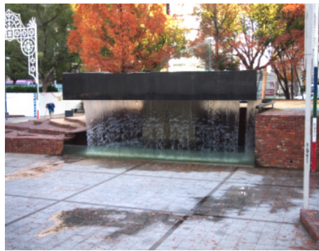
この下が地下室
