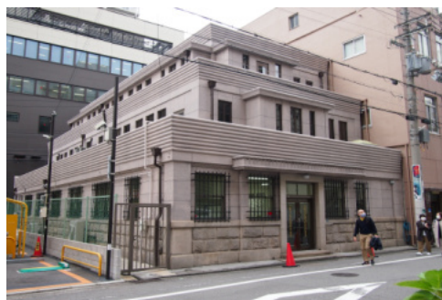
旧「新瑞興」ビルの現状 (元町通3丁目)
