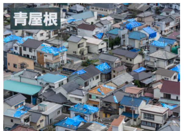
雨に備えて屋根にブルーシートが掛けられた "青屋根" 報道写真より
